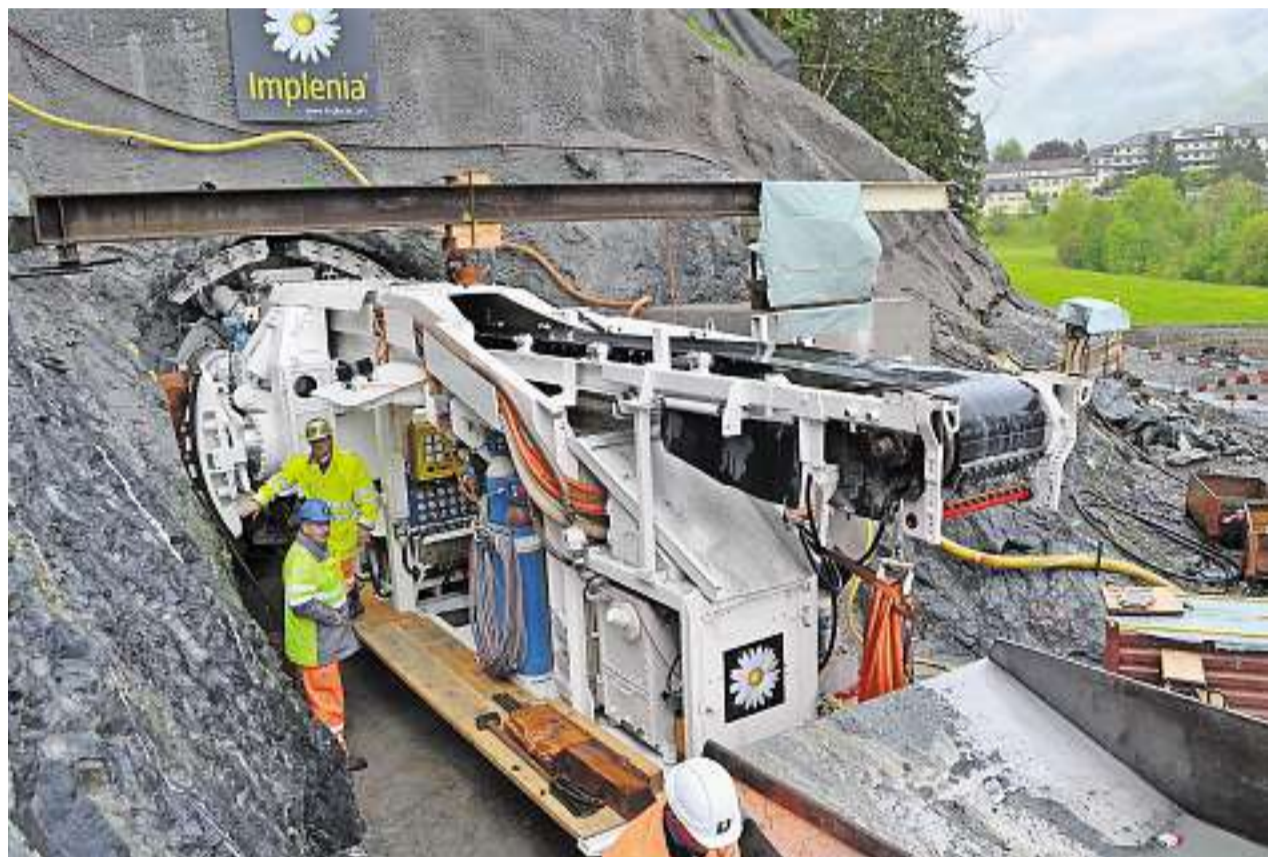
50 Jahre nach dem Bau des Mositunnels erhält er talseits einen Sicherheitsstollen, gestern hat die Bohrmaschine ihre Arbeit dazu aufgenommen. Bild Josias Clavadetscher
